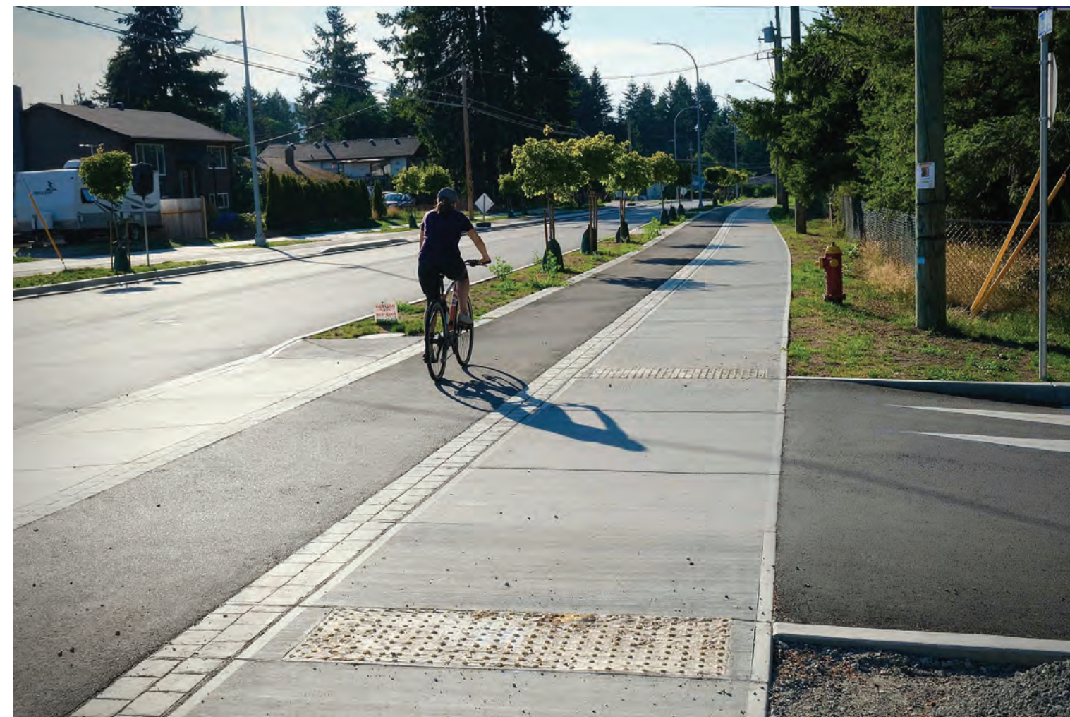
A Acera, bordillo, biciesenda, estacionamiento en la calle, alumbrado público y maceteros de aguas pluviales
